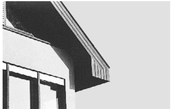
Falsch: zu massives Ortgesimse, bündig mit Dachfläche
