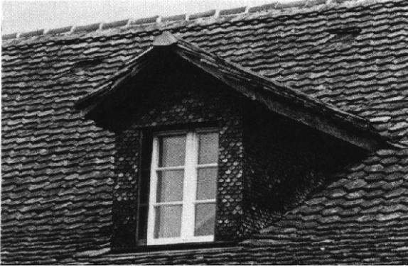
Vorbild: gut proportionierte Giebellukarne hoch und schmal, Fenstereinteilung wie Fassade, Seitenwände im Dachton
