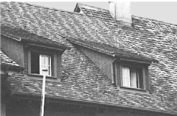
Gut: Schleppgaube schmal und niedrig, Seitenwände im Dachton
